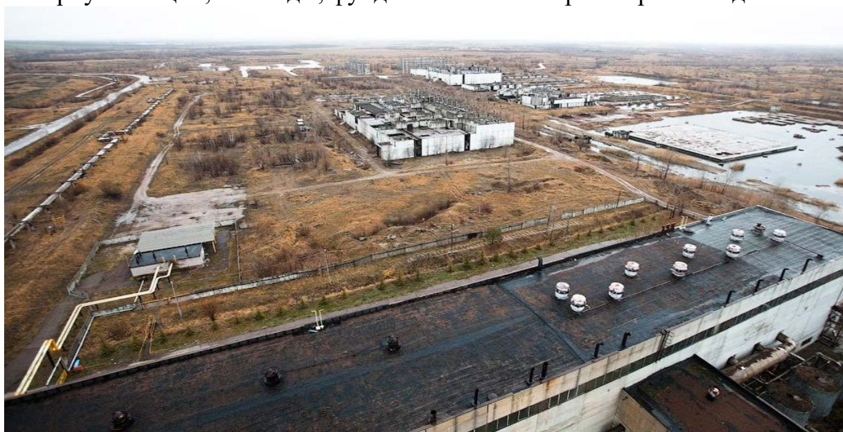
Рис. 3. Недостроенная АЭС. Справа расположены фундаменты для реакторов
