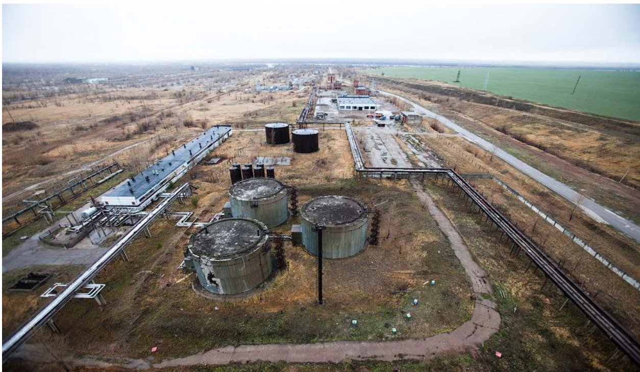
Рис. 2. Недостроенная АЭС. Котельная, водохранилище, административный корпус станции, эстакады, фундаментная плита реакторного отделения
