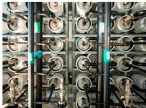
Рисунок 3.9 – Камера с мембранами в осмотической электростанции Statkraft в г. Тофте Норвегия
