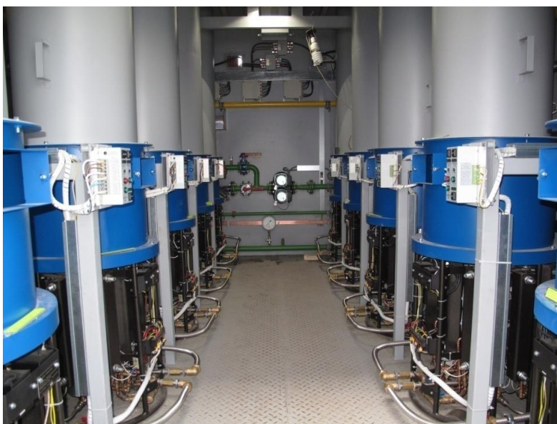
Рисунок 1.24 – Применение термоэлектрического генератора ГТЖ-160 на станции катодной защиты в нефтегазовой отрасли
