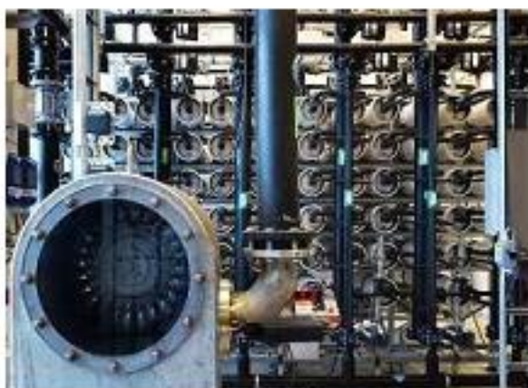
Рисунок 3.9 – Камера с мембранами в осмотической электростанции Statkraft в г. Тофте Норвегия
