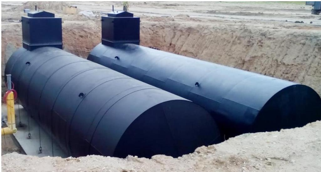
Рисунок 2 – Создание подземных резервуаров
