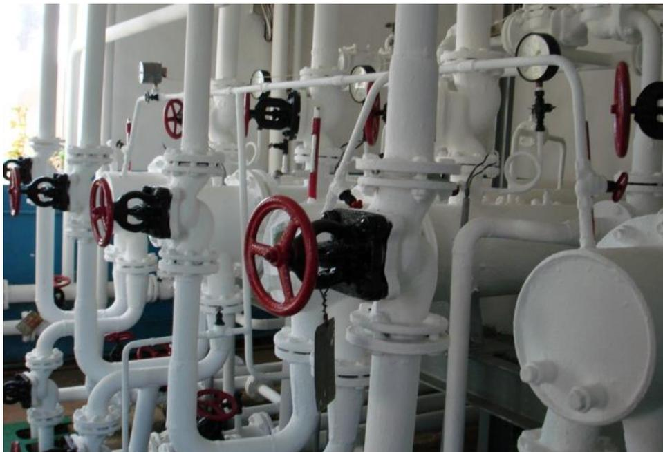
Рисунок 3 – Трубопроводы, покрытые жидкой керамикой
