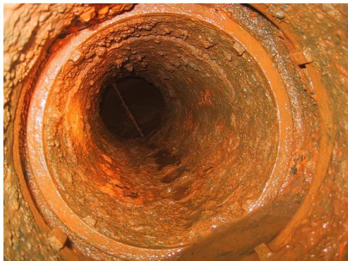
Рисунок 2 – Коррозионный износ трубопровода
