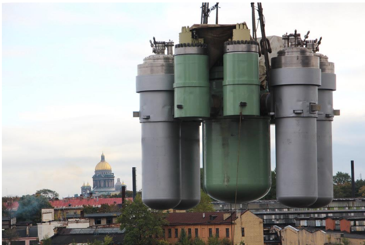
Рисунок 6.1 – Установка парогенерирующего блока (ПГБ) ядерной энергетической установки КЛТ-40С на ПЭБ «Академик Ломоносов». Балтийский завод
