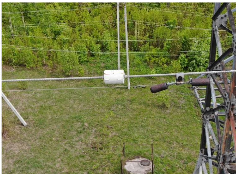
Рисунок 2 – Новая версия датчика состояния ВЛЭП
