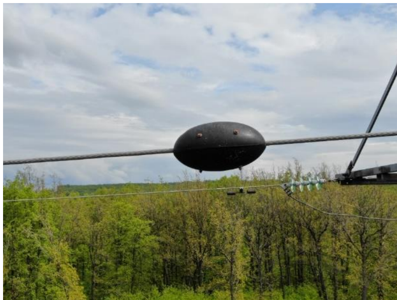
Рисунок 1 – Датчик состояния ВЛЭП
