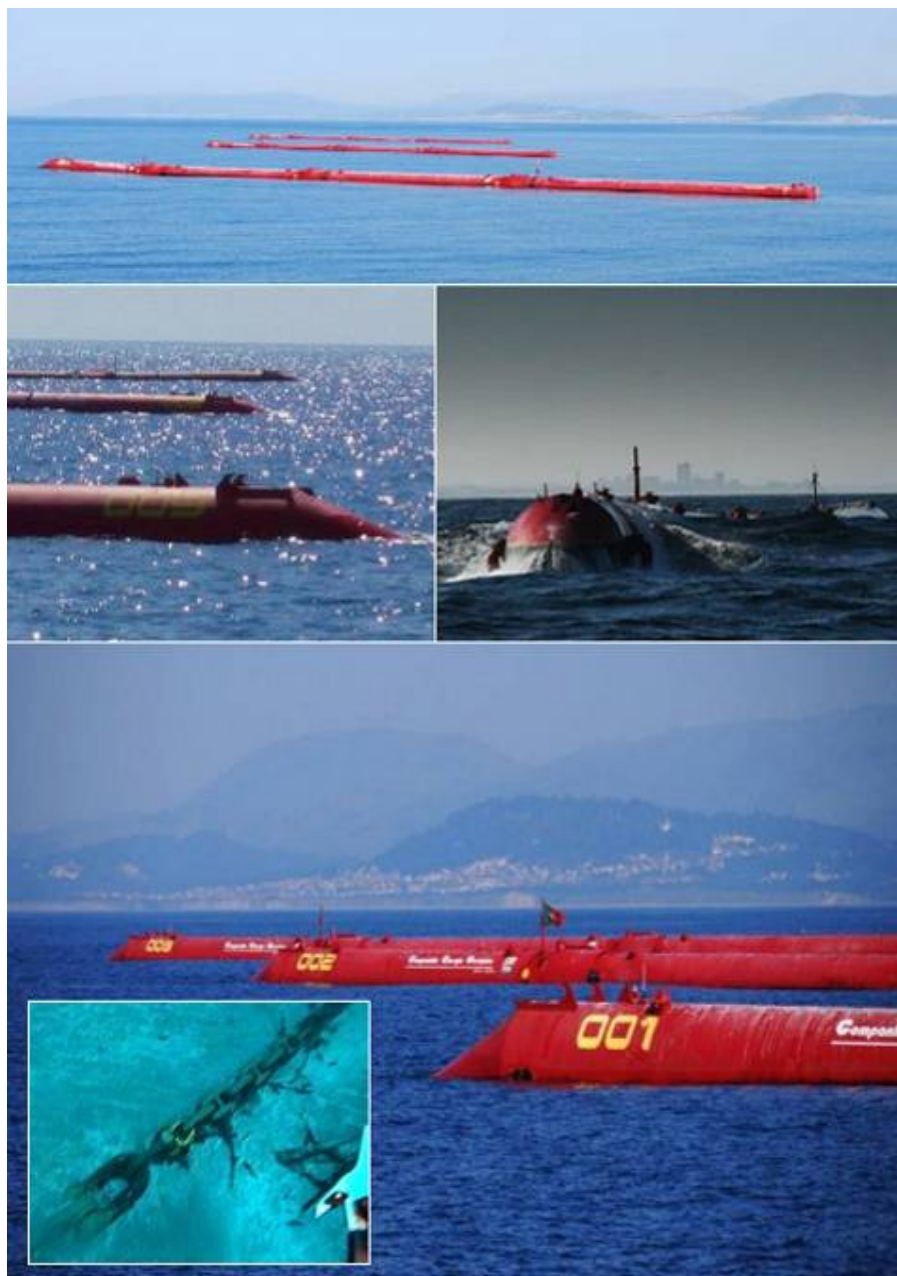
Рисунок 2.2 – Внешний вид волновой электростанции Pelamis P-750
