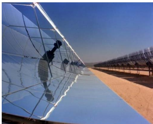
Рисунок 1.11 – Параболический концентратор Крымской электростанции
