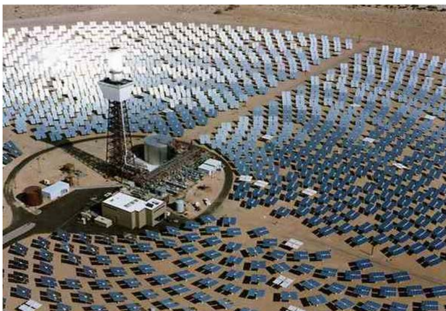
Рисунок 1.9 – Солнечная электростанция термoeлектрического типа в Калифорнии (США) мощностью 12,5 МВт
