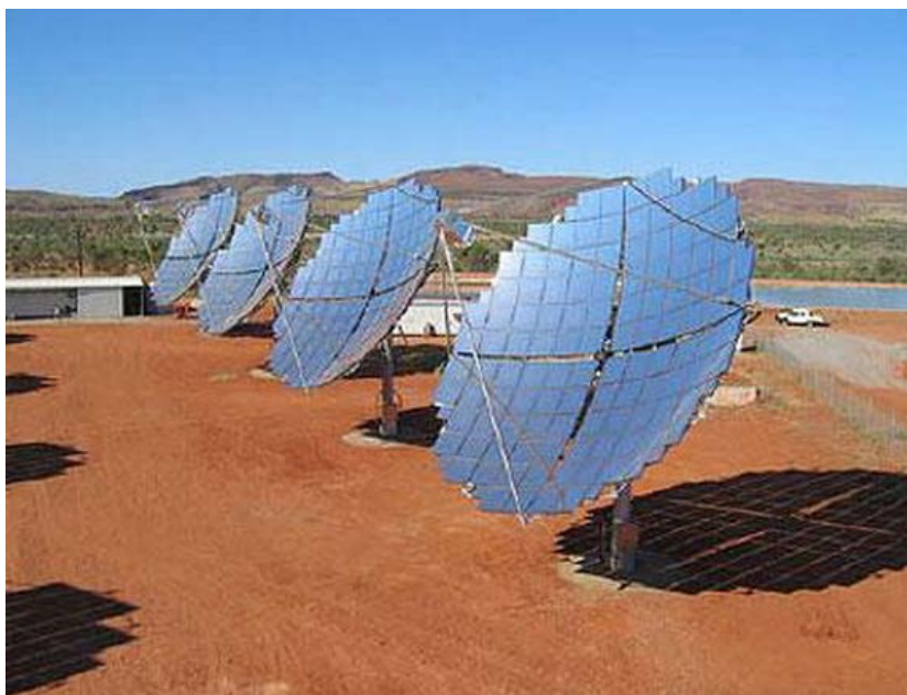
Рисунок 1.12 – Концентратор Австралийской солнечной электростанции
