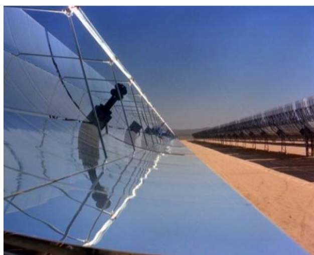
Рисунок 1.11 – Параболический концентратор Крымской электростанции
