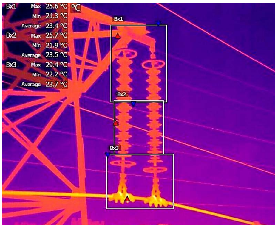
Рисунок 1. Замер температуры гирлянды изоляторов
