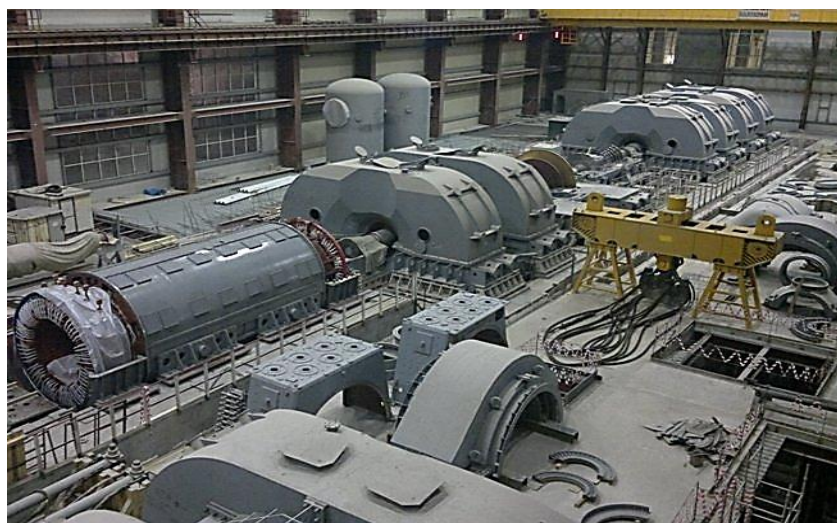
Рис. 4- Турбина К-1200-6,8/50
