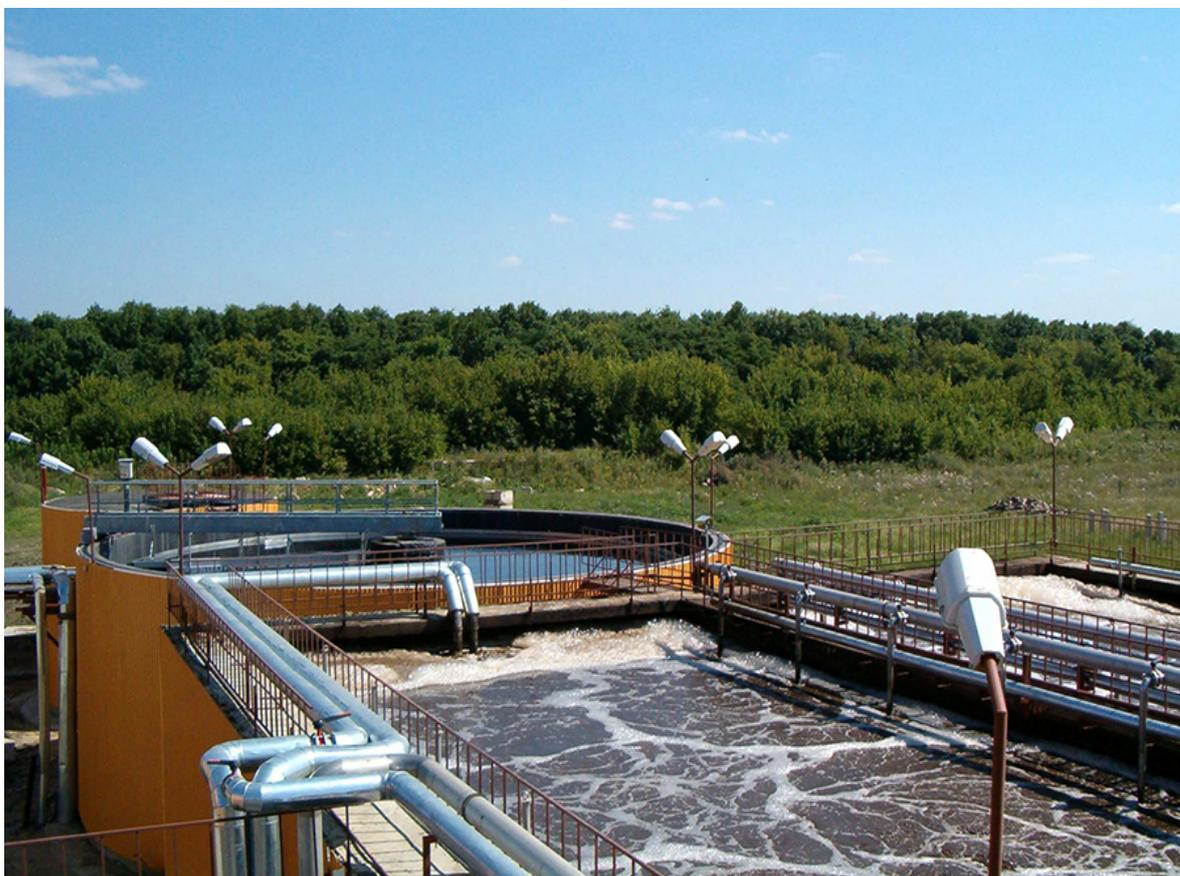
Рис. 2.16. Биохимическая очистка сточных вод
