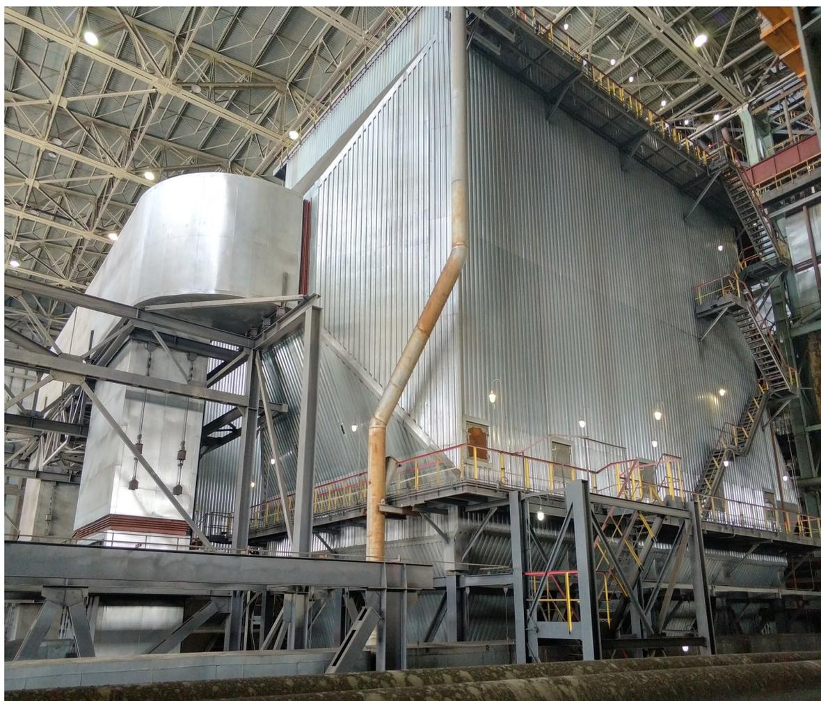
Рис. 2.12. Электрофильтр на ТЭЦ. Степень очистки газов 99,7 %
