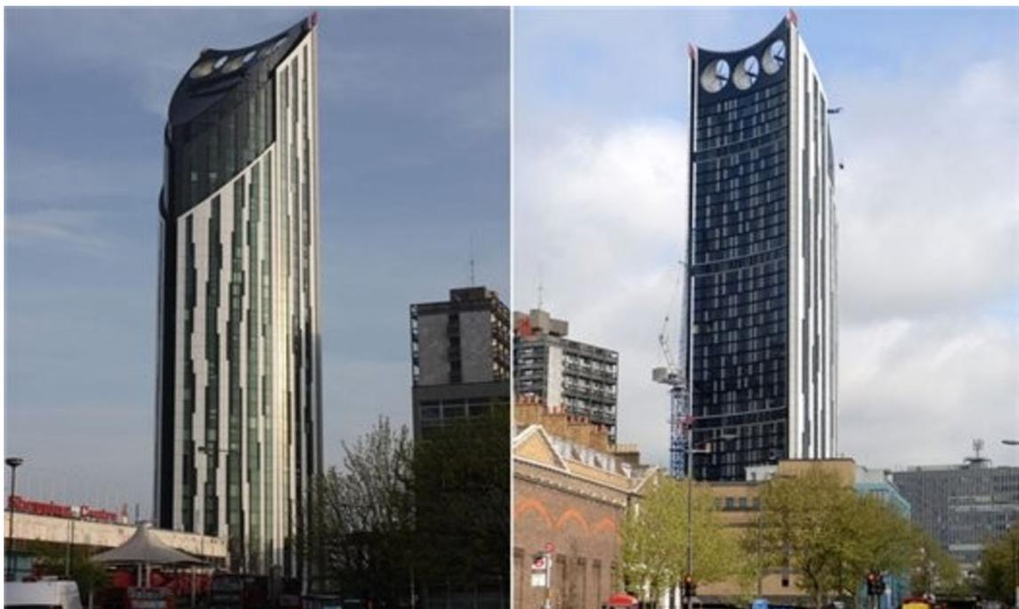
Рис. 1.7. Небоскреб с ветроэлектрогенераторами
