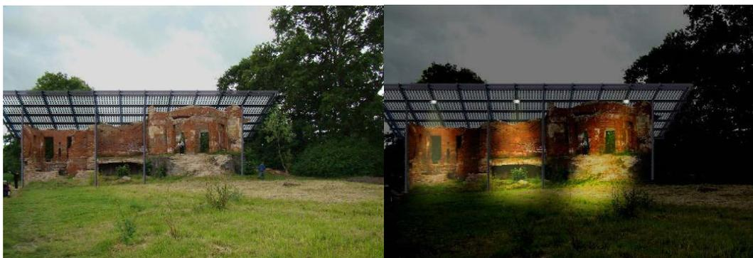
*Рисунок 2. Модель энергопитающей конструкции покрытия над руинами «Розового павильона» в г. Петергофе (день и ночь)*
