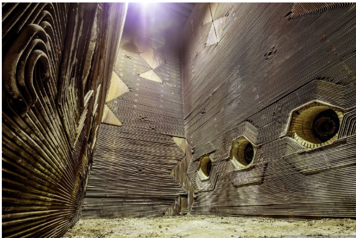
Рис. 3.27. Топка парогенератора
