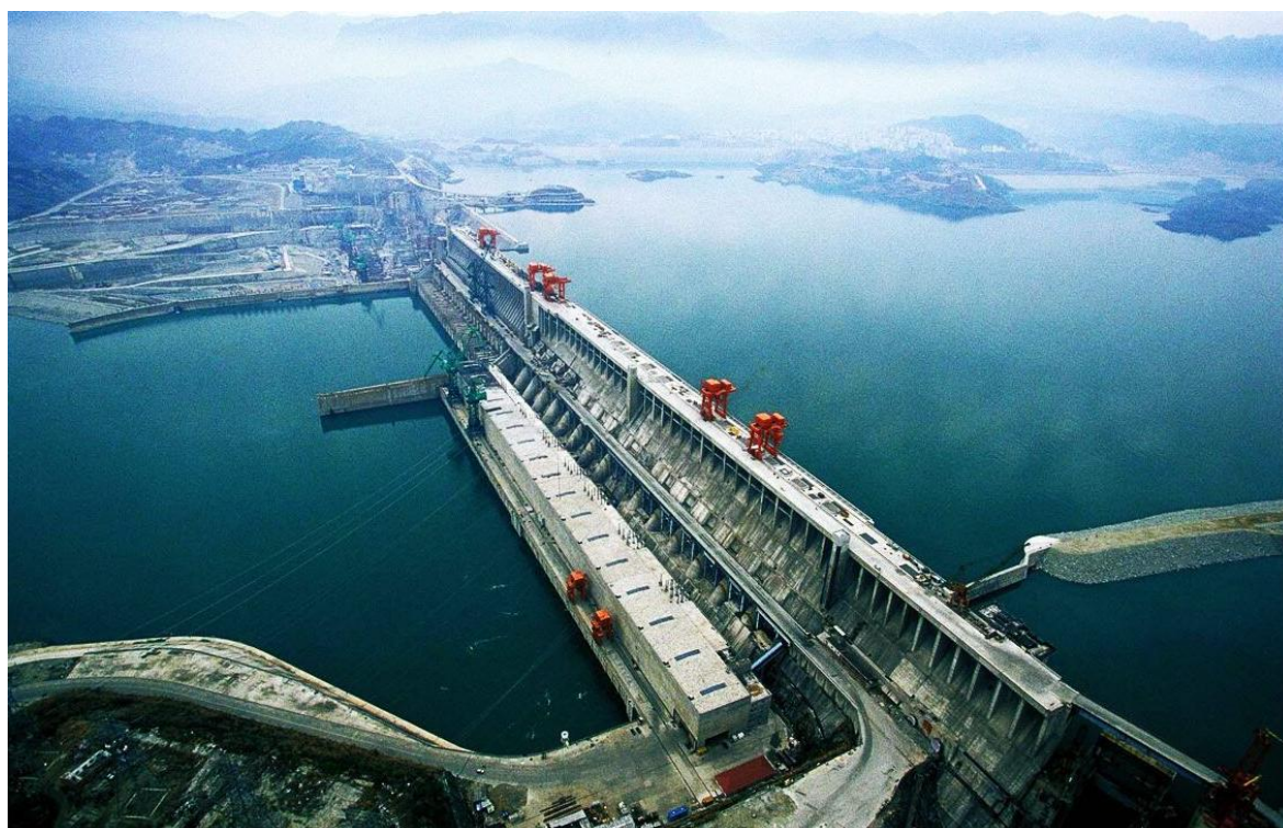
Рис. 1.12. Самая большая в мире ГЭС «Три ущелья» мощностью 22,4 ГВт, река Яндзы, Китай
