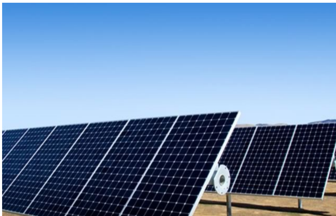
Рис. 1.21. СЭС в районе Долины Антилоп в западной части пустыни Мохаве в южной Калифорнии, мощностью 579 МВт, используется 3,8 миллиона солнечных панелей
