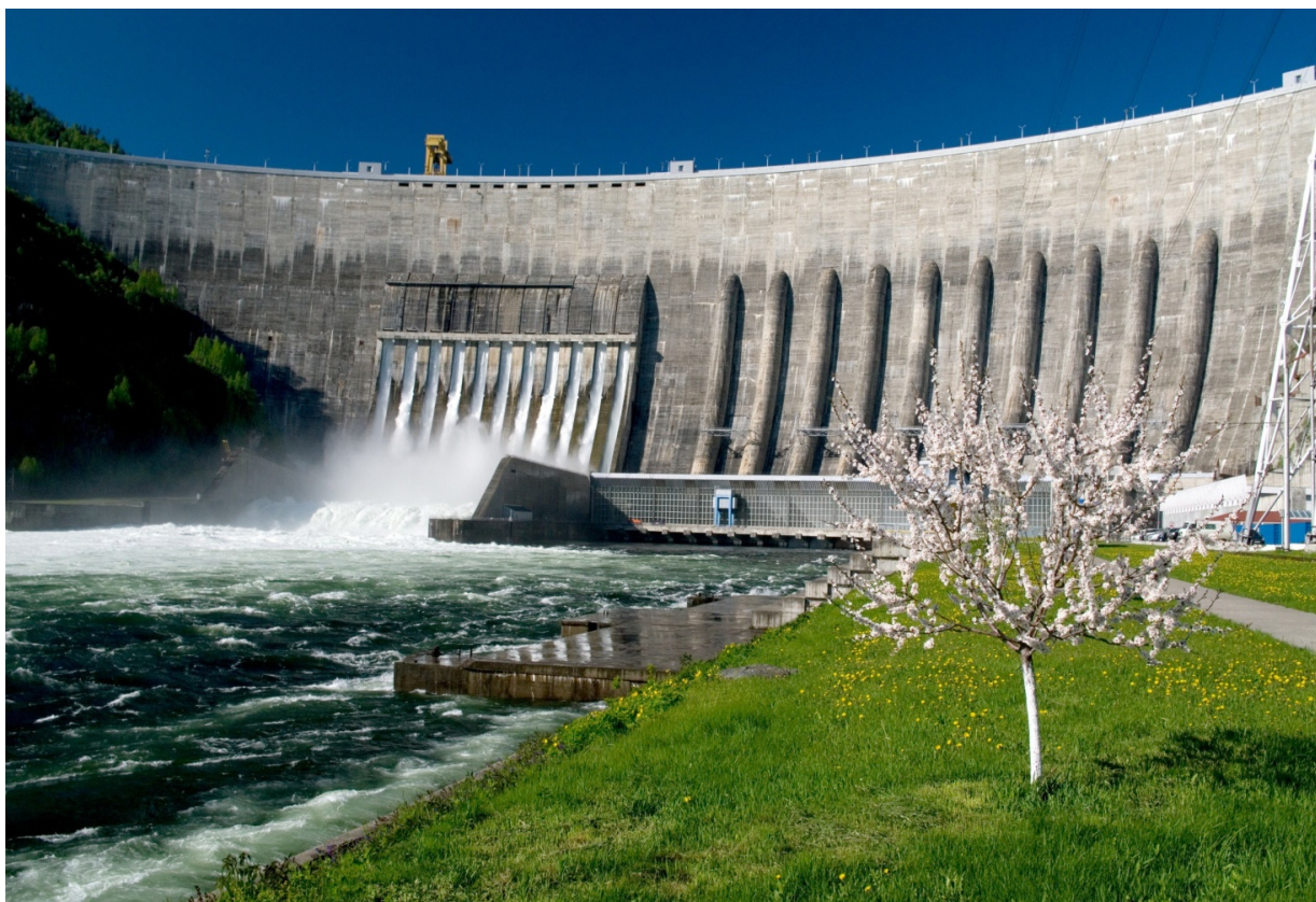
Рис. 1.10. Саяно-Шушенская ГЭС мощностью 6,4 ГВт на реке Енисее, на границе между Красноярским краем и Хакасией, у посёлка Черёмушки возле Саяногорска
