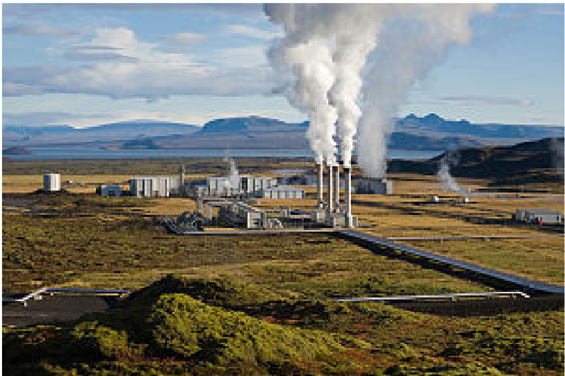
Рис. 1.28. ГеоТЭС мощностью 140 МВт в Кении
