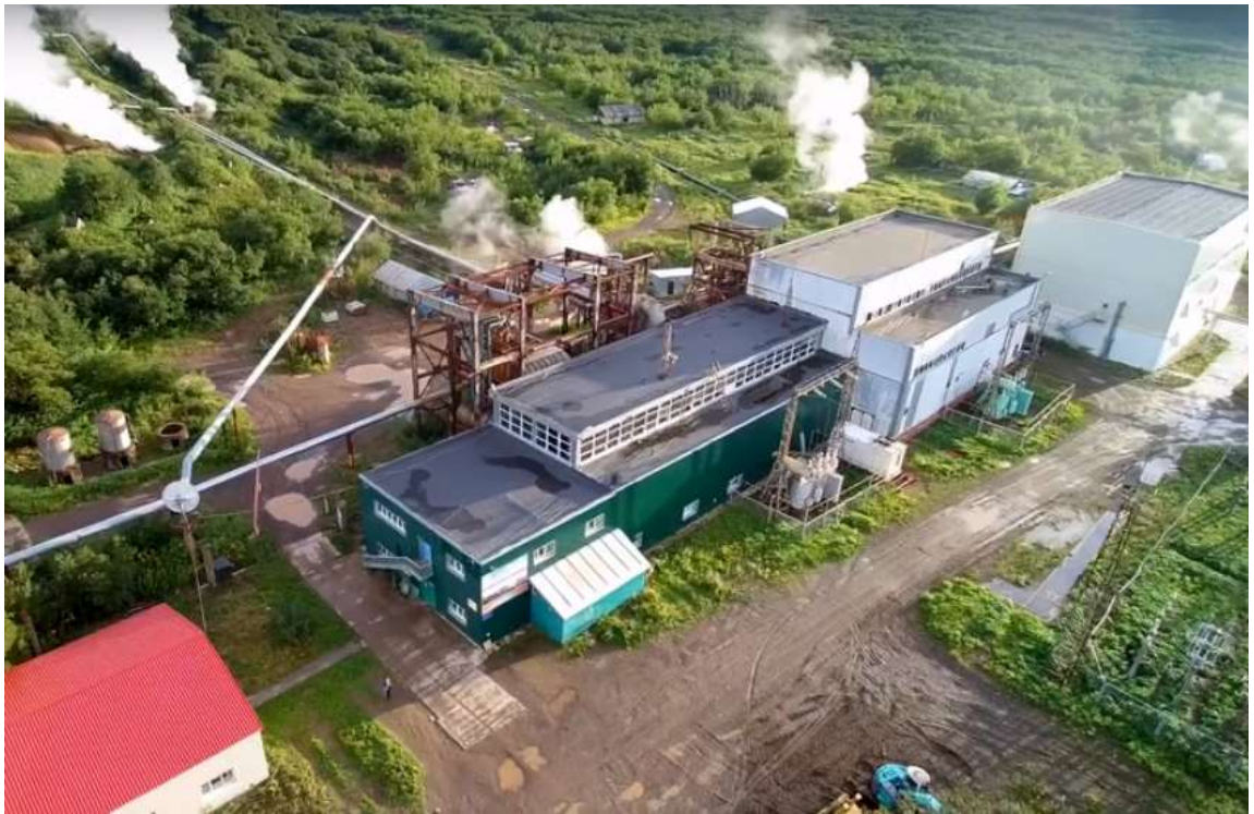
Рис. 1.24. Паужетская ГеоТЭС мощностью 12 МВт
