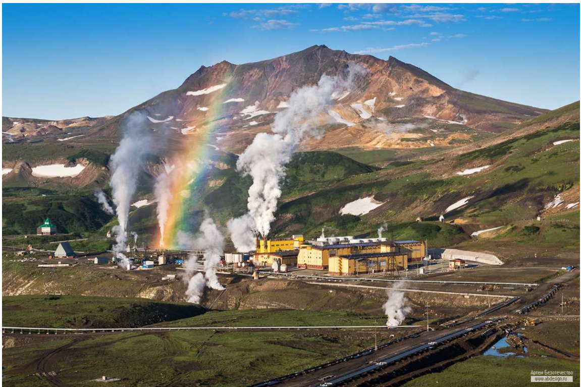
Рис. 1.25. Мутновские ГеоТЭС суммарной мощностью 62 МВт, обеспечивают 30 % выработки электроэнергии в Центральном камчатском энергоузле
