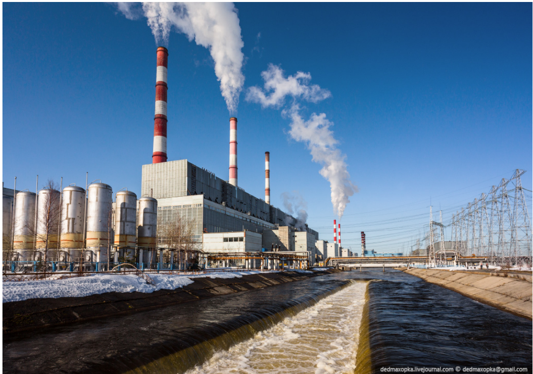
Рис. 1.2. Сургутская ГРЭС-2. Производственные корпуса
