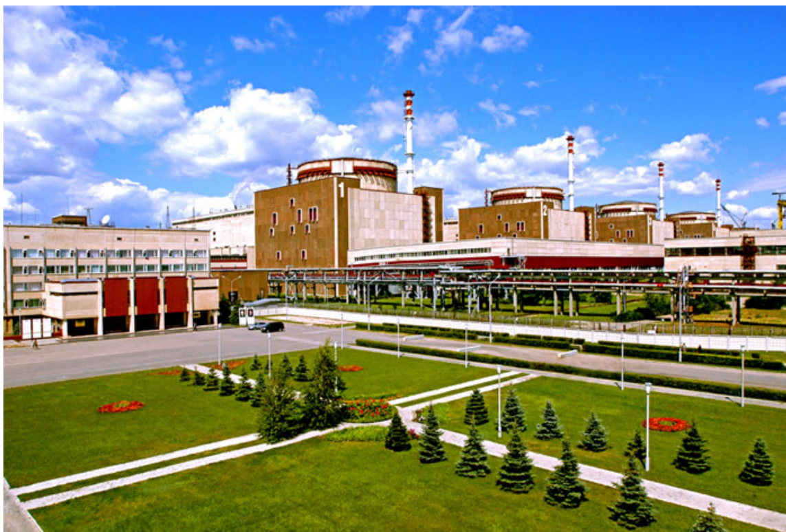
Рис. 1.6. Балаковская АЭС, Саратовская область мощностью 4 ГВт
