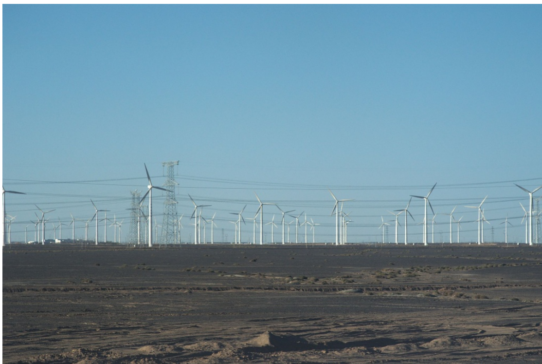
Рис. 1.18. Комплекс ВЭС «Ганьсу», г. Цзюцюань, провинция Ганьсу, Китай; установленная мощность 20 ГВт
