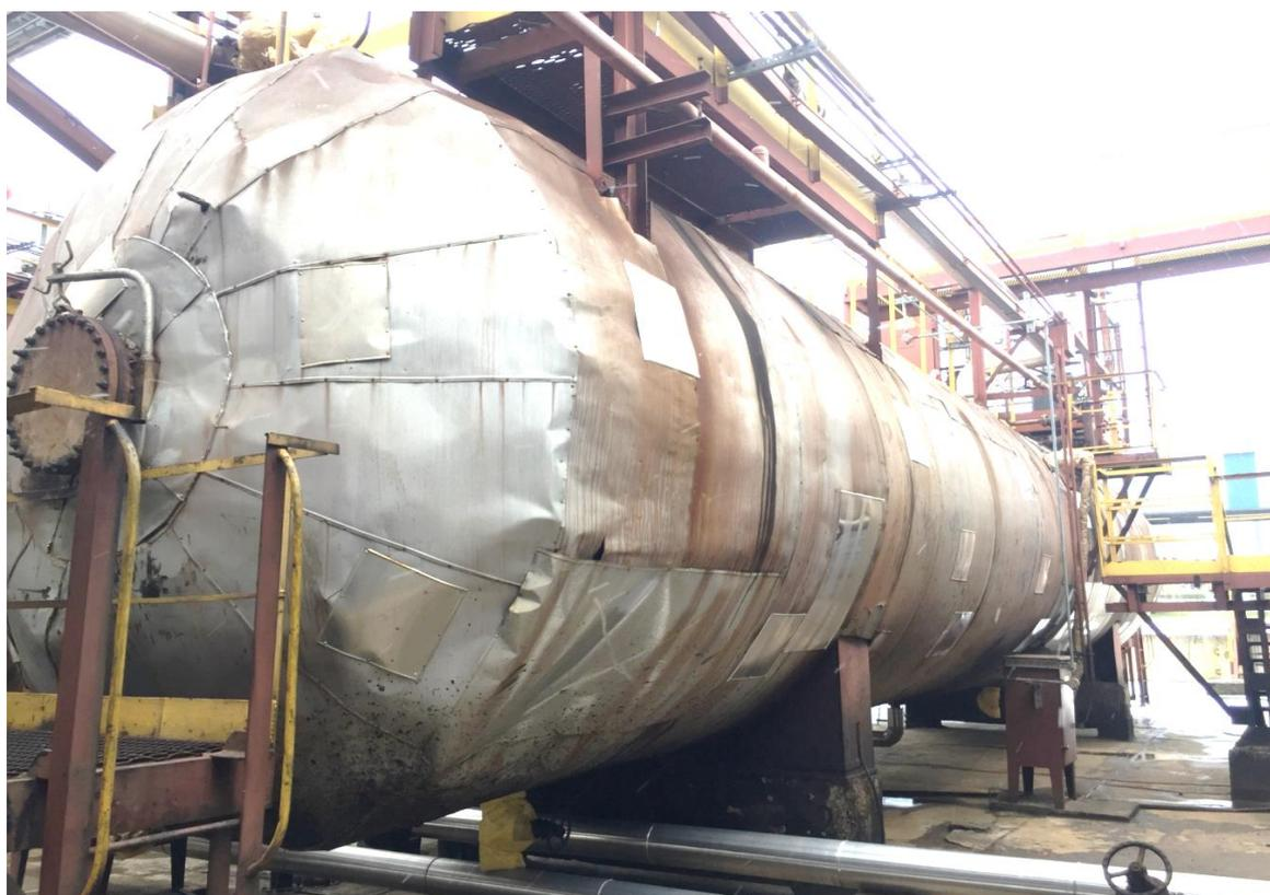
*Рисунок 1. Внешний вид электродегидратора на Киришском нефтеперерабатывающем заводе*
