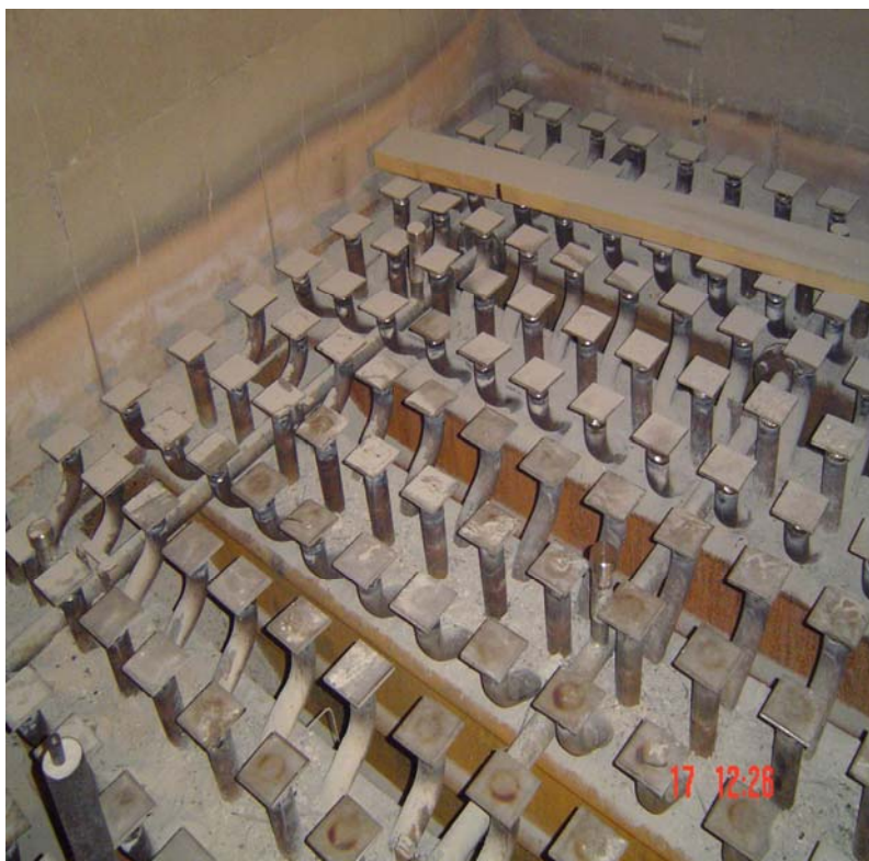
Рис. 23. Распределительная решетка типа НУВЕХ
