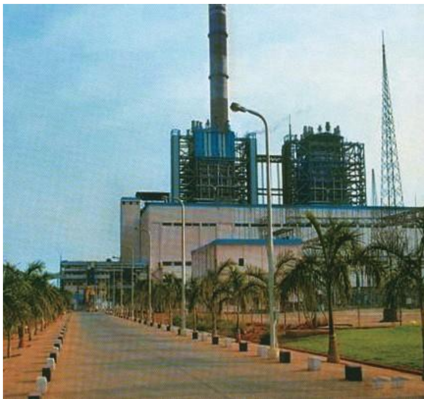
Рисунок 1.8 – ТЭС «Нейвели» (Индия) – 2×210 МВт – с котлами башенного типа Еп-690-15,4-540 ЛТ
