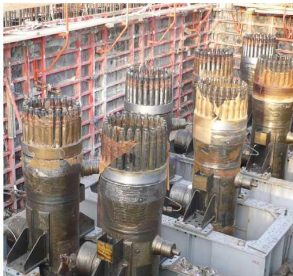
Рис.4.28. Вид парогенератора Н-272 на верхней (а) и нижней (б) опорах модулей
