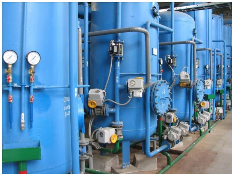
Рис. 7. Химводоподготовка в котельной
