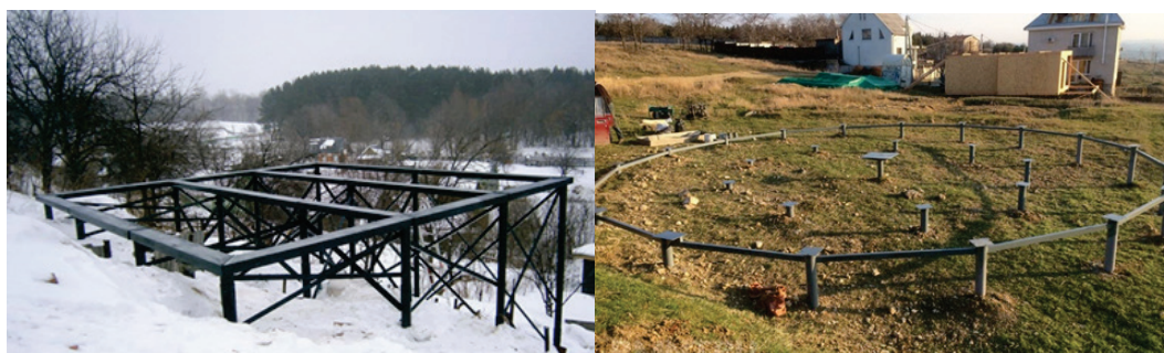
Рисунок 5 – Свайная конструкция
