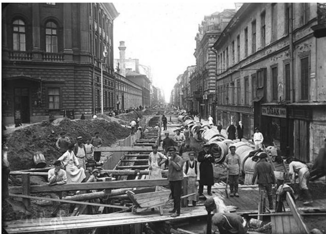
Рис. 78. Строительство канализации в Ленинграде в 1920-е годы
