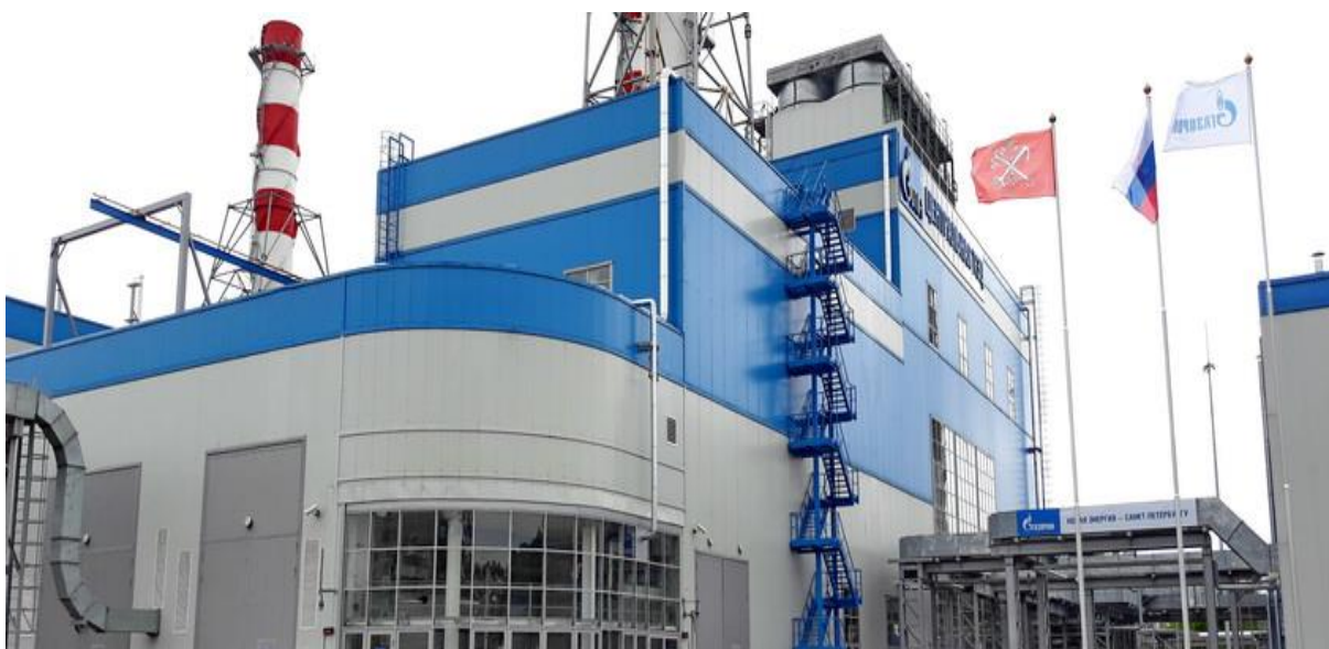
Рис. 3. Центральная ТЭЦ г. Санкт - Петербург
