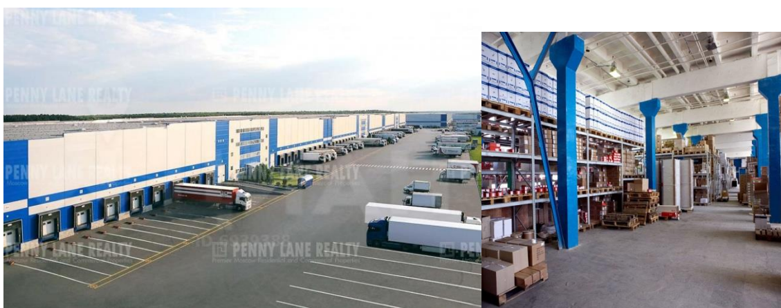
Рис.6. Общий вид и интерьер холодильной станции
