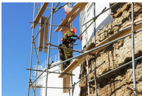
Рис. 4 - Изолирование резервуара
