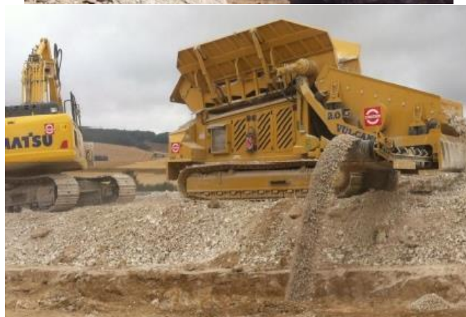
Рис. 1. Техника для дробления крупнообломочного грунта подсыпки и засыпки подземного трубопровода
