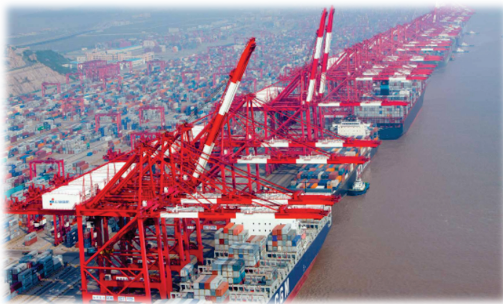
Рис. 12. Фото контейнерного терминала в Шанхае
