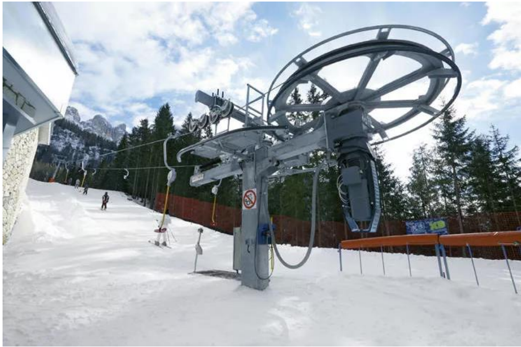
Рис. 5. Общий вид конечной станции бугельного подъёмника
